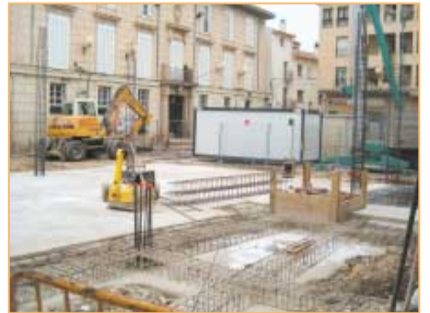
Planta baja del centro cívico en construcción
