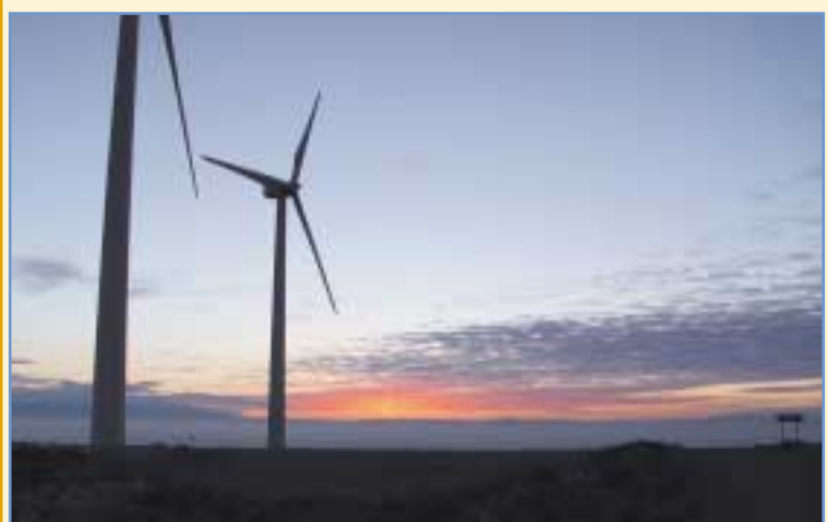
Queda por elegir el tipo de molinos que se instalarán en Valtierra.
