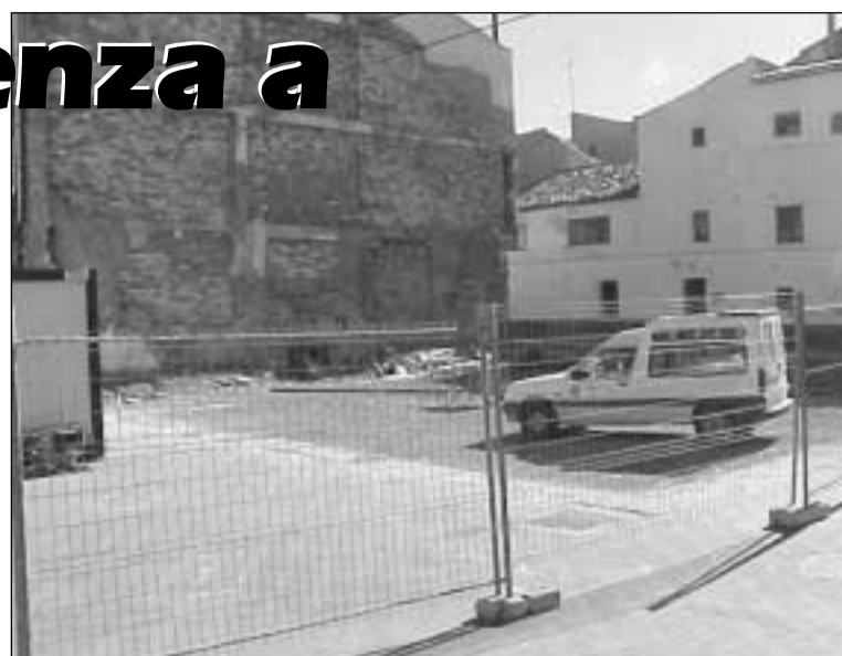
Solar vallado y listo para el inicio de las obras.
