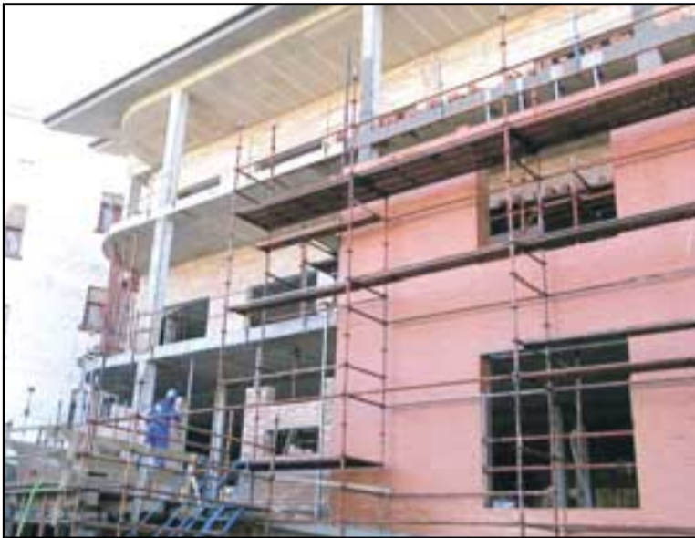
Trasera del edificio de la residencia en construcción
