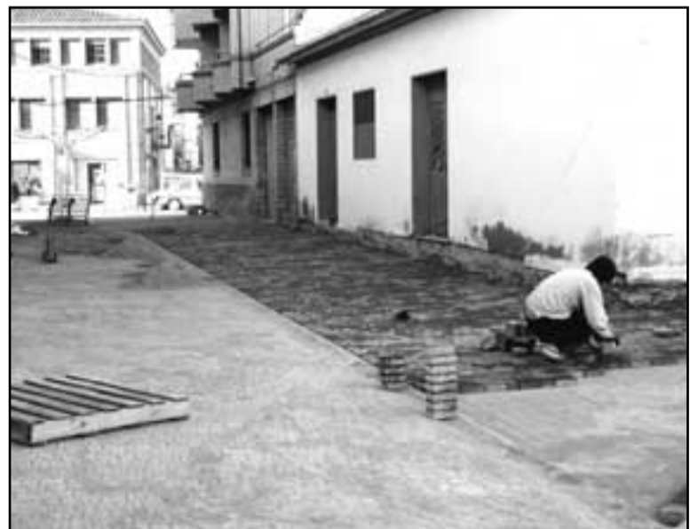
Colocación de adoquines en la calle Palacio
