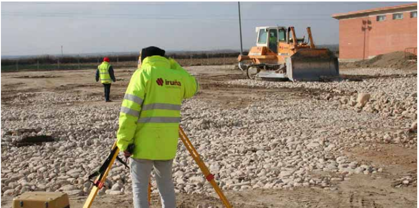
Vista del campo de fútbol durante las obras. / ENFOQUE.
