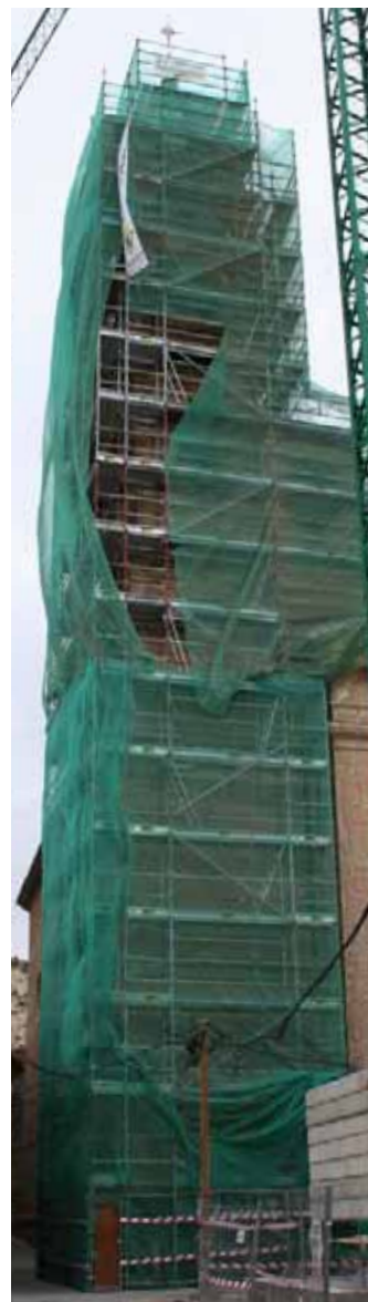
Los andamios cubren la torre. / ENFOQUE.
