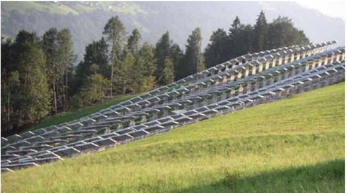
Vista de placas similares a las que se instalarán en Valtierra. / ARCHIVO.
