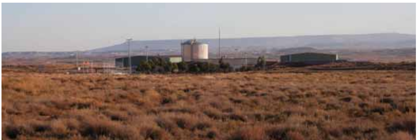
Vista del vertedero de El Culebrete, destino de todos los residuos. / ENFOQUE.
