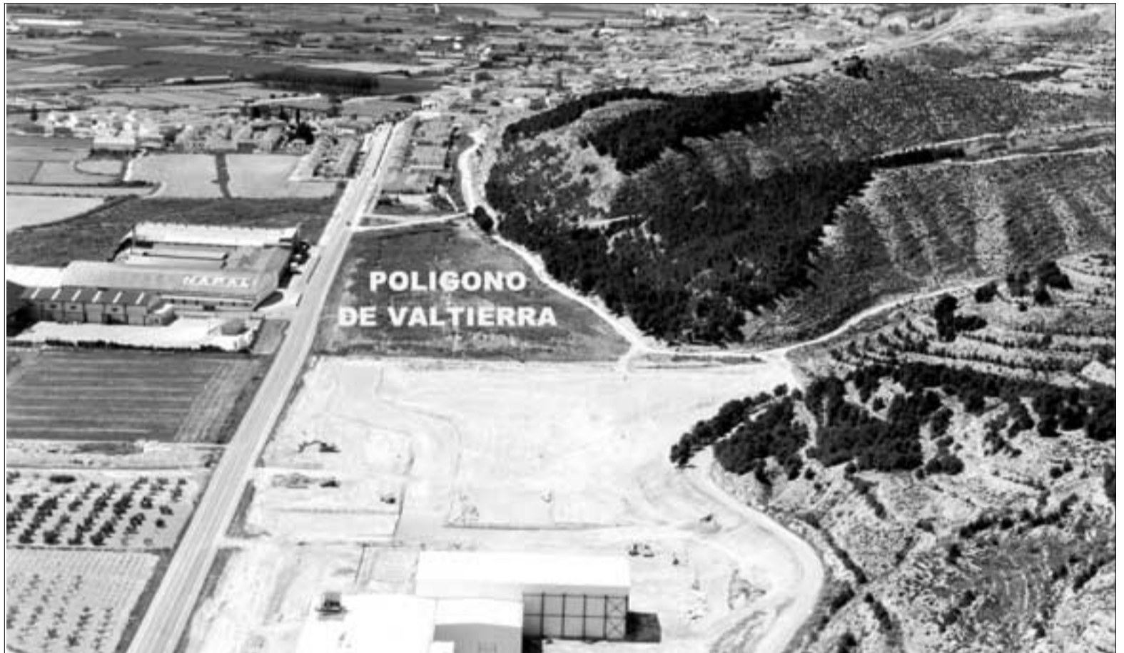
foto aérea del polígono mancomunado Arguedas-Valtierra. Al fondo de la imagen el solar de Valtierra destinado a zona industrial.
