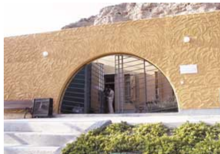
Cuevas de Valtierra, puerta principal, acceso a recepción.
