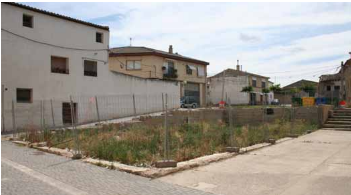
Estado actual del solar situado en la Calle Justavilla números 6 y 7. / ENFOQUE.
