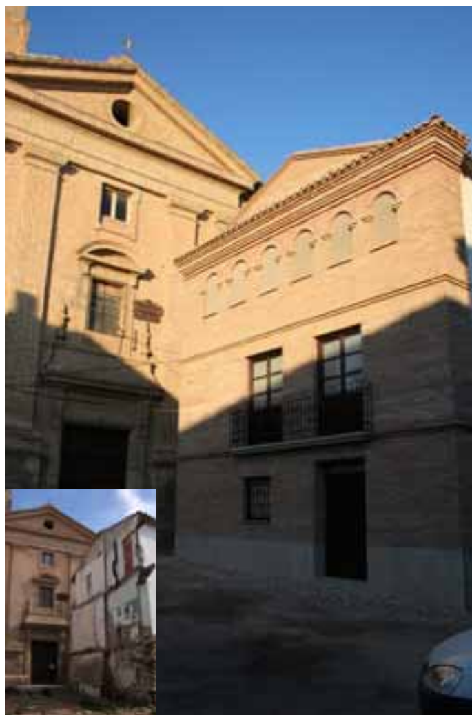
La nueva fachada guarda la estética del entorno. / ENFOQUE.
