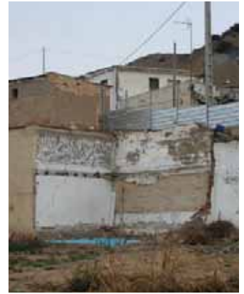
Solar donde se encontraban las viviendas.
