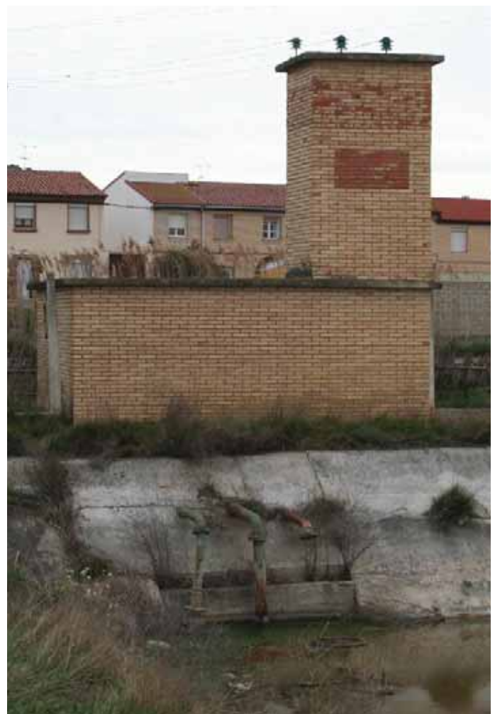
Antiguas instalaciones donde se ubicarán los tanques de tormenta. / ENFOQUE.
