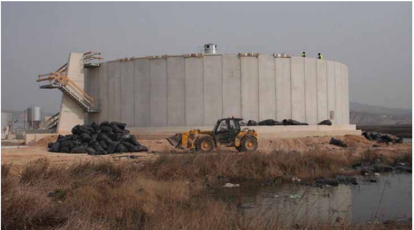
La nueva depuradora en construcción. / ENFOQUE.
