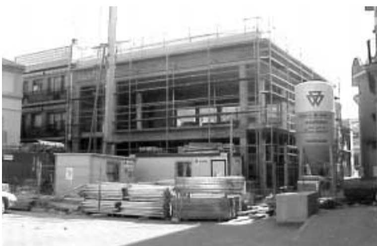
El mal tiempo ha repercutido en la marcha de las obras del centro
