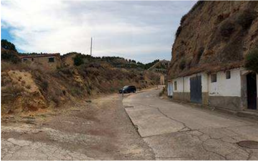
ESTADO ACTUAL ZONA DE LA PUENTE
