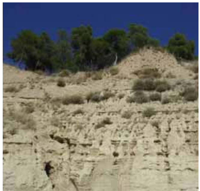
Vista de los surcos causados por la caída del agua. / ENFOQUE.
