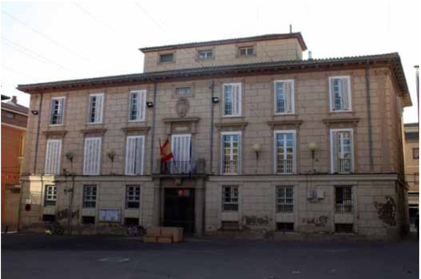
Vista de la Casa Consistorial./ ENFOQUE.
