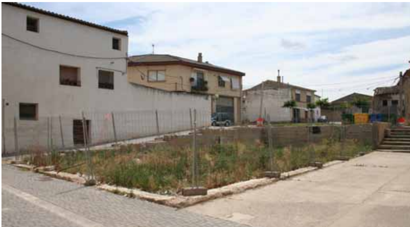
Estado actual del solar situado en la Calle Justavilla números 6 y 7. / ENFOQUE.
