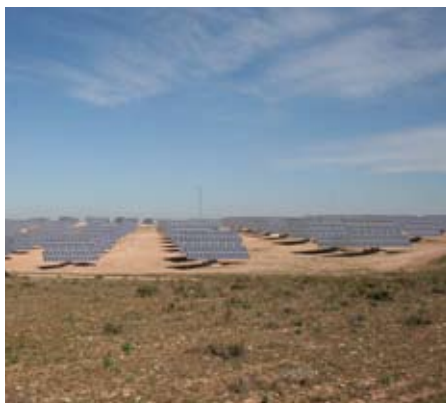
Primeras placas colocadas. / ENFOQUE
