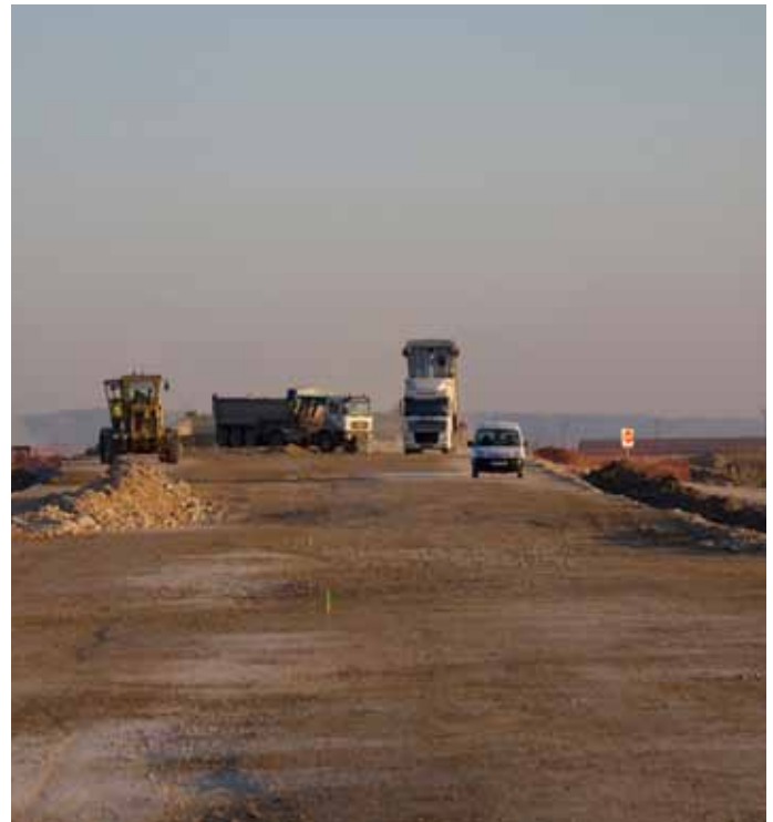
Los trabajos de la variante van ya muy avanzados. / ENFOQUE.
