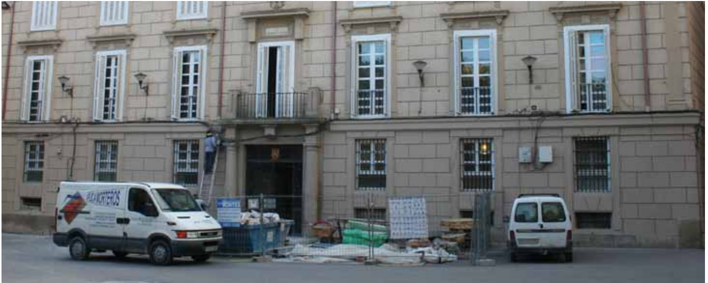
Los operarios preparan los últimos retoques en la fachada. / ENFOQUE.
