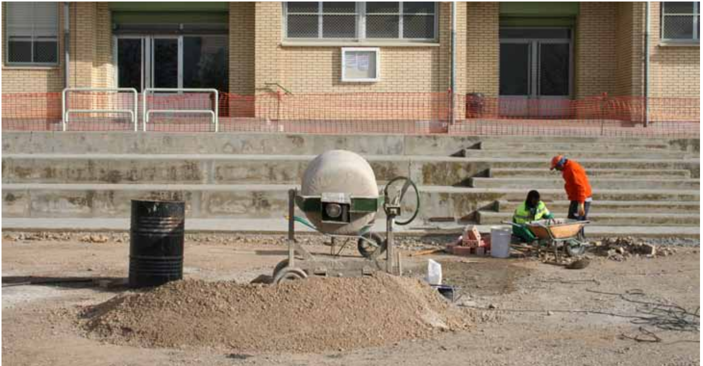
Los operarios continúan trabajando en el patio del colegio. / ENFOQUE.
