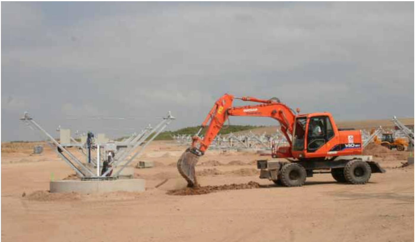
Parte del proceso de colocación de los nuevos seguidores. / ENFOQUE.
