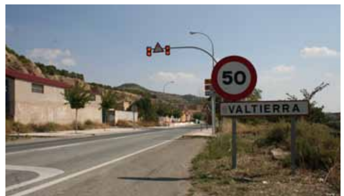
Estado actual de la travesía de Valtierra. / ENFOQUE.
