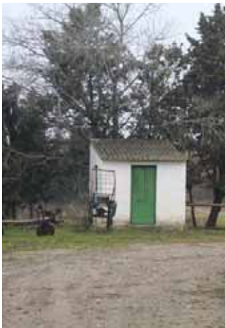
Una de las casetas de la finca.
