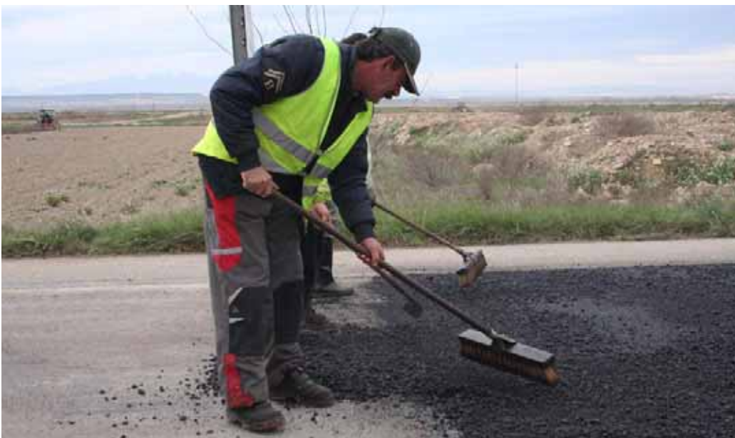
Un trabajador de la construcción realiza labores de asfaltado. / ENFOQUE.
